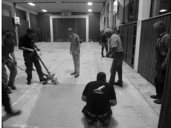
beit beim Entfernen des PVC-Bodens und der darunter liegenden Spanplatten. **Es bestätigte sich, dass die Entscheidung, den alten Schwingboden zu belassen, vollkommen richtig war.**
